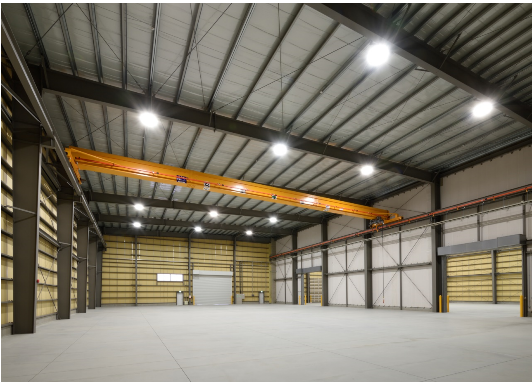
【太田流通センターA棟 内観】
